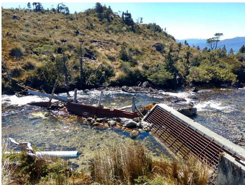
Figura 4. En el río Eba se observan restos de la represa realizada voluntariamente por los edeninos a la izquierda de la fotografía para conducir agua hacia la tubería por el filtro a la derecha debajo de la fotografía.
